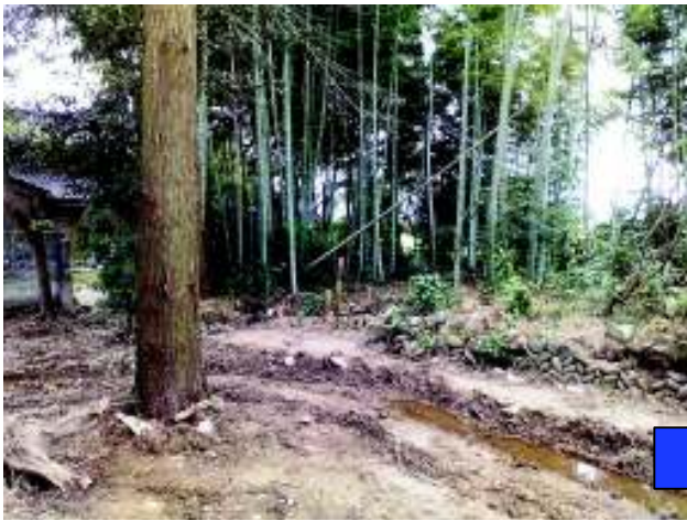
南西角整地前
