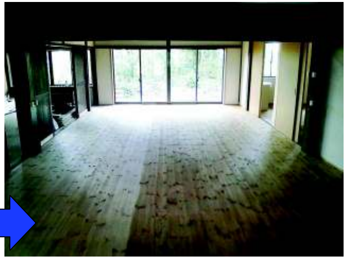
建物内装工事後
