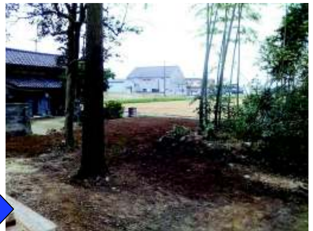
南西角整地後
