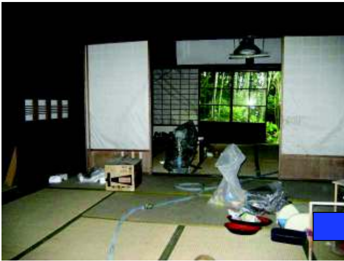
建物内装工事前
