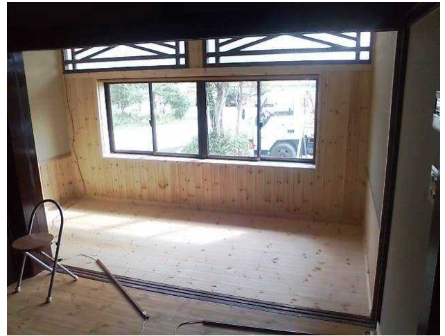
東側・玄関室内工事
