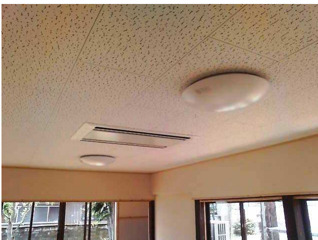
南西側天井・照明・空調
