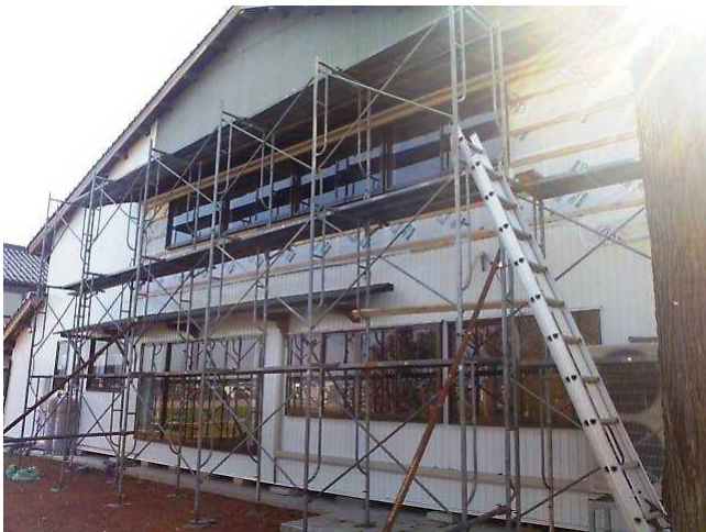
西側・2階サッシ・外壁
