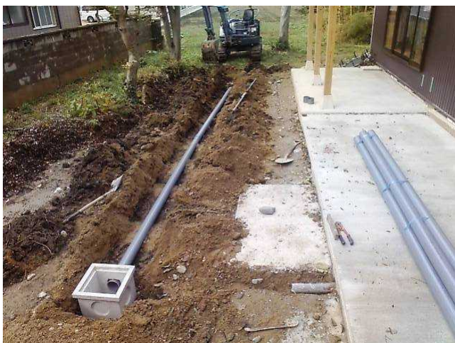
南西側・雨水工事
