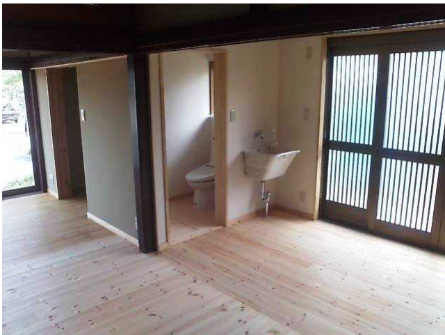
東南側・南玄関・トイレ・物置
