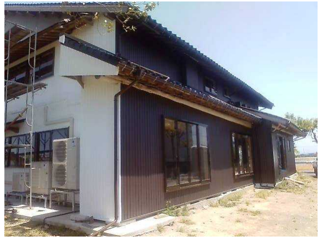
南西側・外壁・サッシ
